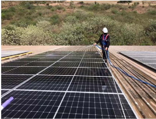
ใช้น้ำฉีดบริเวณแผงเซลล์อาทิตย์ฉีดตามแนว แรงโน้มถ่วงโลก
