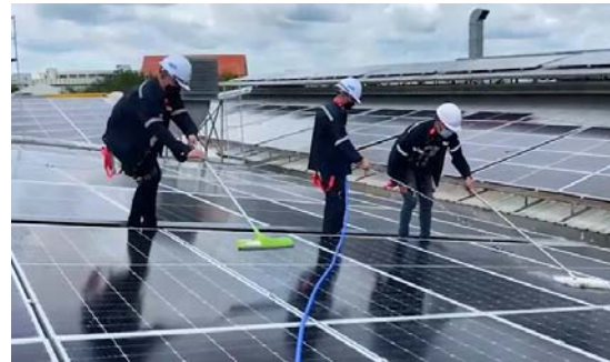
ใช้ไม้ไล่ไล่ให้น้ำบริเวณที่ถูกและฉีดน้ำให้น้ำออกจากแผง
