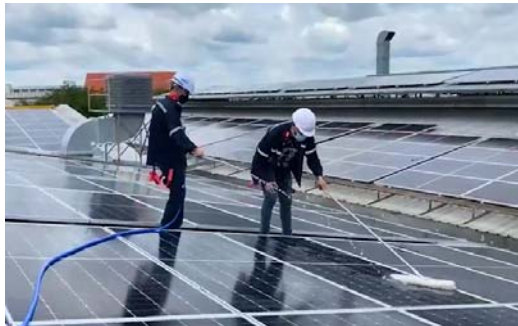
ไล่ฉีดน้ำในบริเวณที่ถูกด้วยไม้ม็อบให้พุ่งออก
